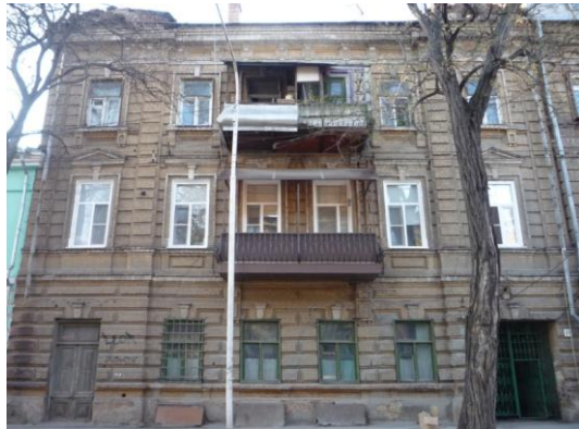
Abbildung 26: Fassade des begutachteten Bauwerks: Bauwerke vor 1917
