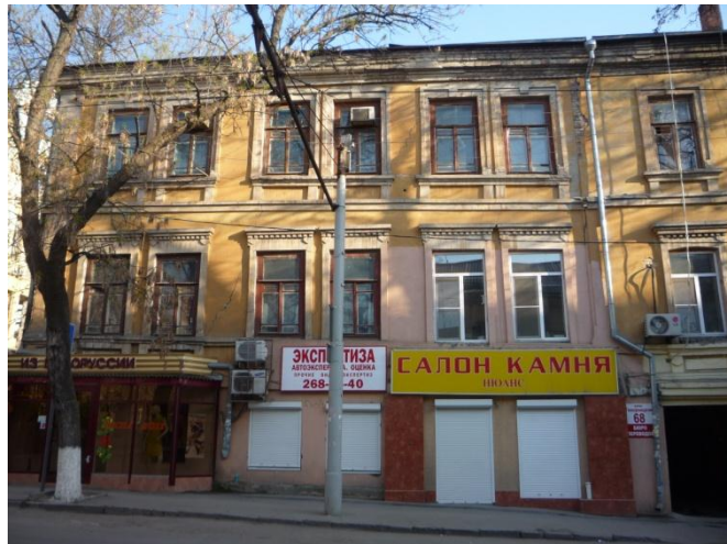
Abbildung 60: Hauptfassade des Bauwerks, Objekt 3: Temernitskaya Str. 68
