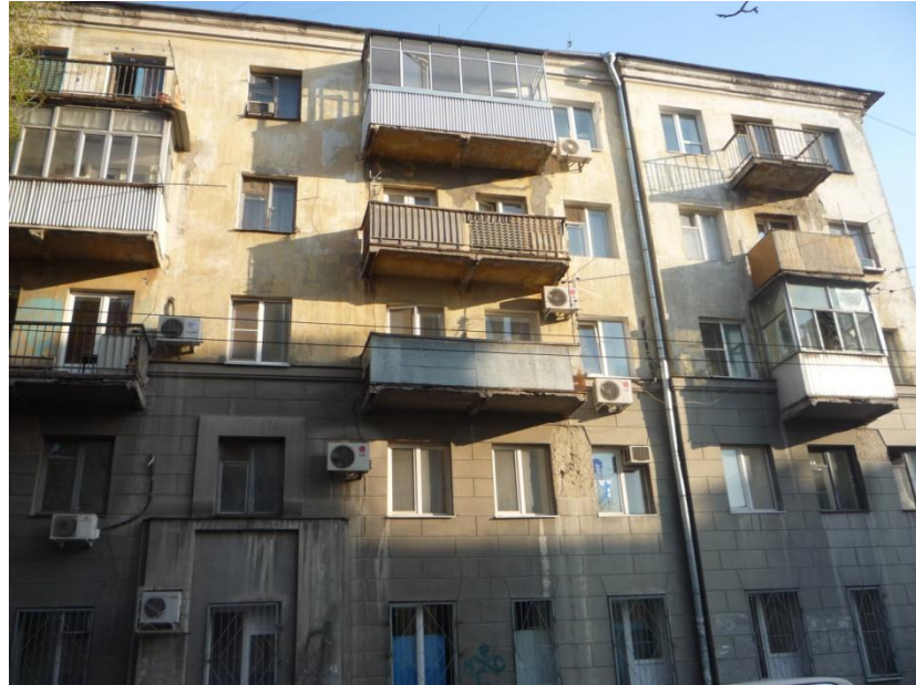
Abbildung 62: Hauptfassade des Bauwerks, Objekt 4: Moskovskaya Str. 76
