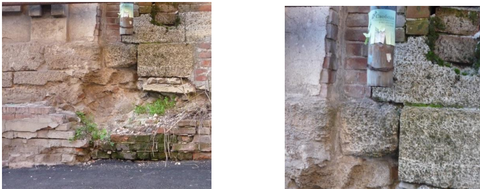
Abbildung 25: Ungewünschte Begleiter der Fassaden in Rostov-am-Don: Algen und Moos
